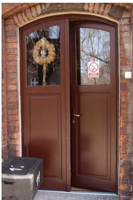
Fot. 7: Drzwi nr 1 (wejściowe)
