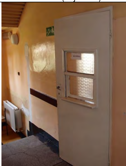
Fot. 9: Drzwi do kuchni (do zamurowania)
