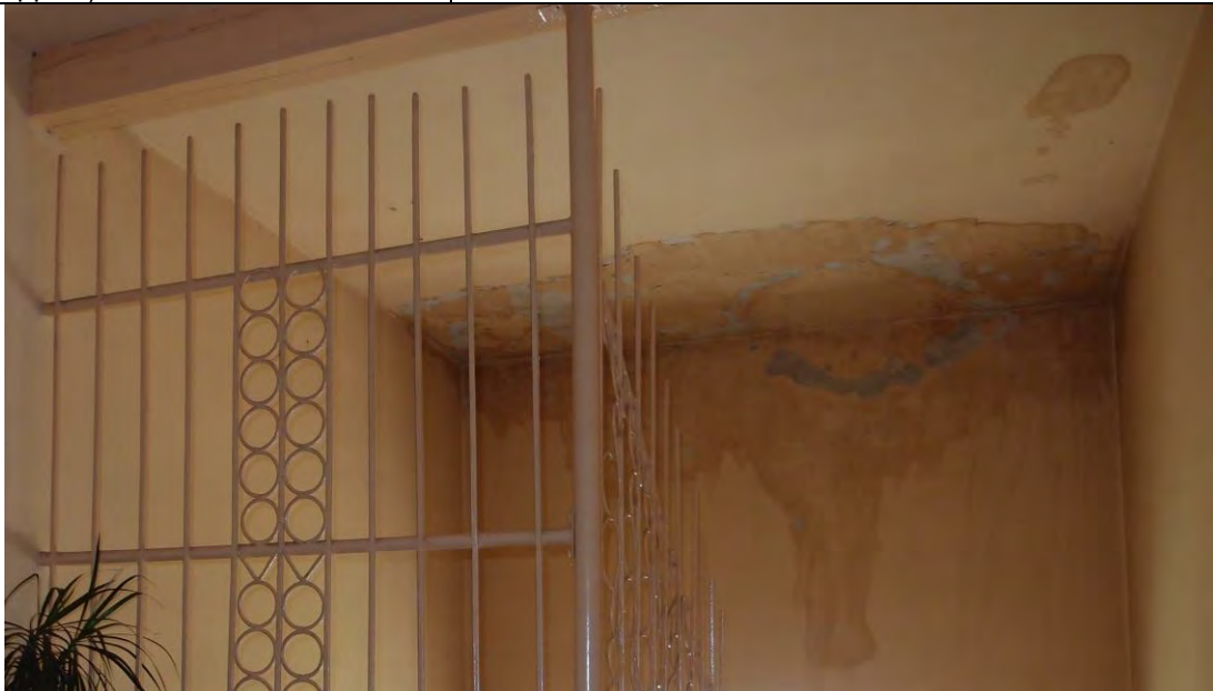
Fot. 17: Strop nad I piętrem (wstawienie klapy oddymiającej)
