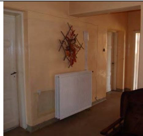
Fot. 15: Piętro I korytarz południowy (zamknięcie klatki przez wstawienie drzwi ppoż.)
