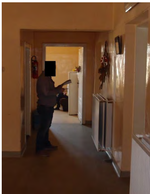
Fot. 13: Piętro I korytarz północny (zamknięcie klatki przez wstawienie drzwi ppoż.)
