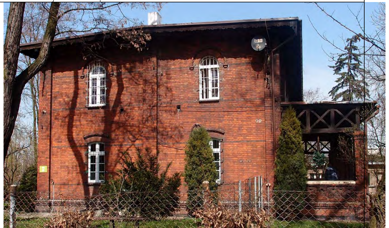
Fot. 6: Elewacja południowa pawilonu XIII
