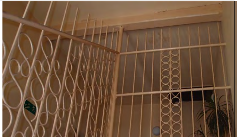
Fot. 16: Strop nad I piętrem (wstawienie klapy oddymiającej)
