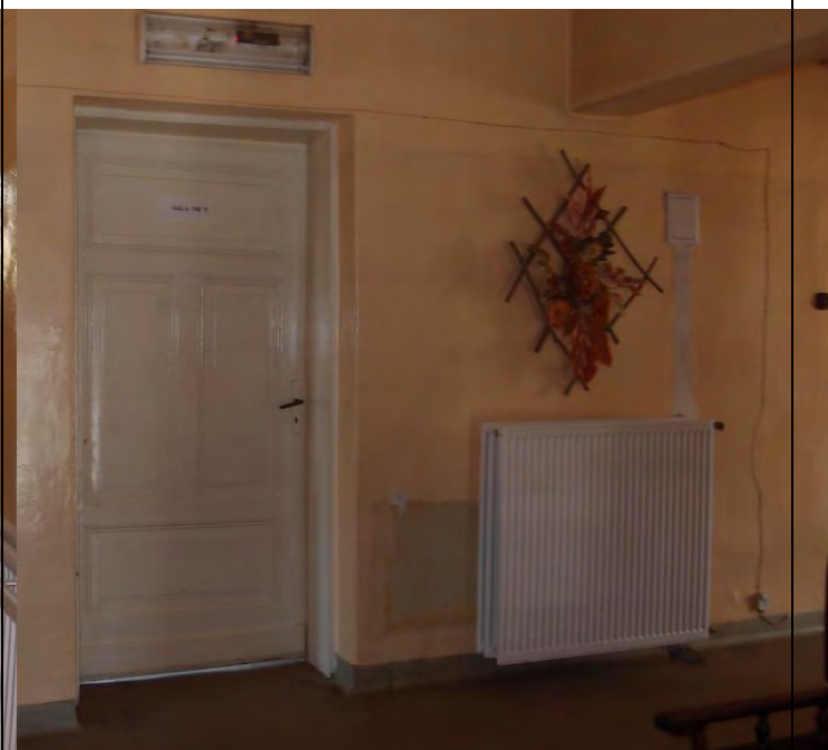
Fot. 14: Piętro I korytarz wschodni (zamknięcie klatki przez wymianę drzwi na drzwi ppoż.)
