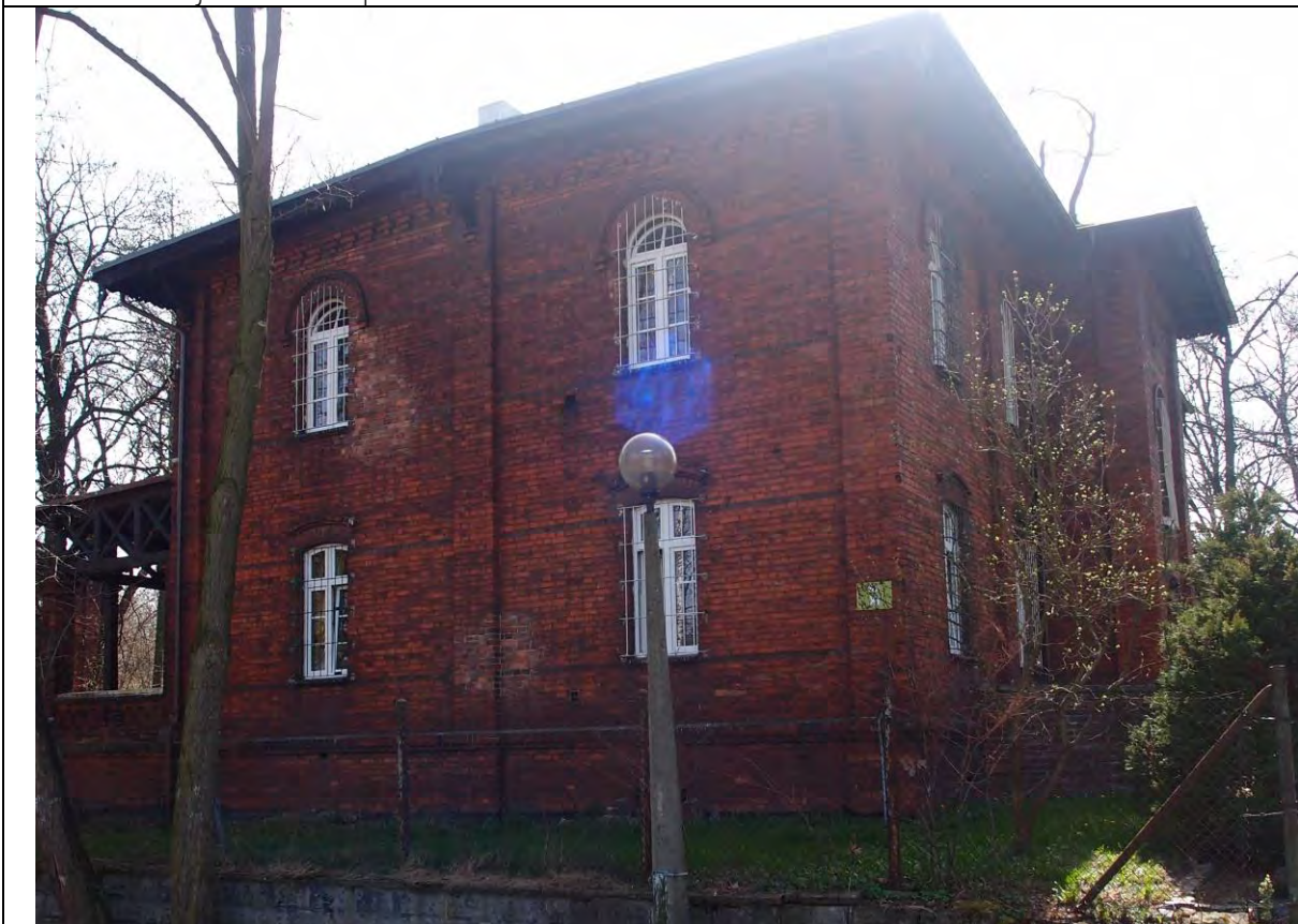
Fot. 4: Elewacja południowo - wschodnia pawilonu XIII
