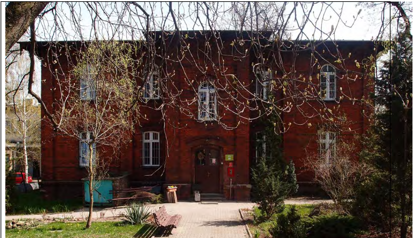
Fot. 3: Elewacja zachodnia pawilonu XIII
