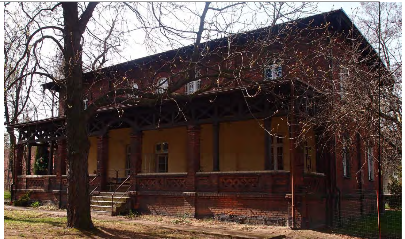
Fot. 5: Elewacja wschodnia pawilonu XIII
